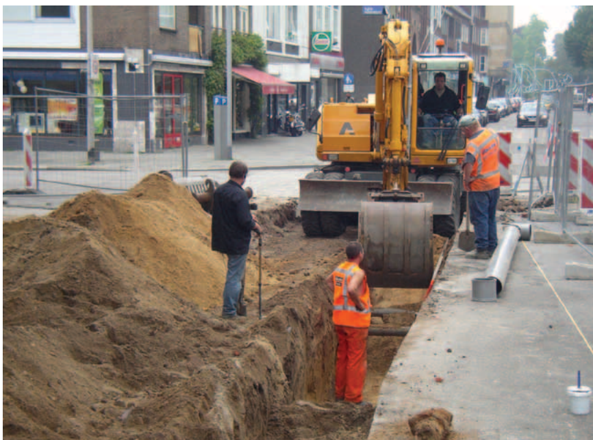
Figuur 2.2 Het begeleiden van de aanleg van een smalle rioeringsleuf (werkput 8), met op de achtergrond de Hertogstraat en het Kelfkensbos. BK
