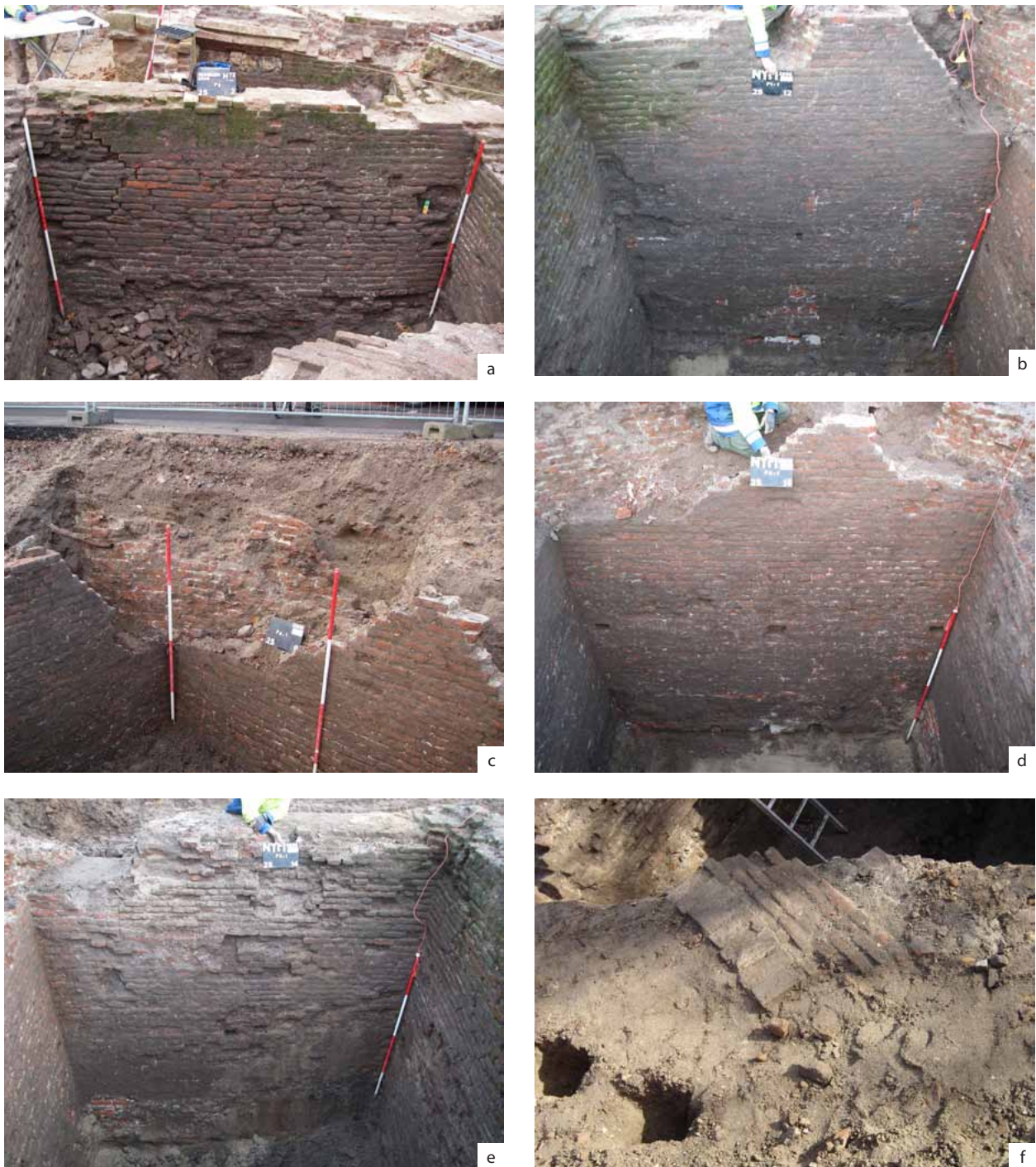
Figuur 5.17. Het muurwerk van structuur F: de binnenzijden van de grote kelder. a zuidoostmuur, b zuidwestmuur, c westelijke hoek met uitbraaksleuf, d noordwestmuur, e noordoostmuur, f bestrating bovenin de vulling van de kelder (S25.3). WK/BK/JO
