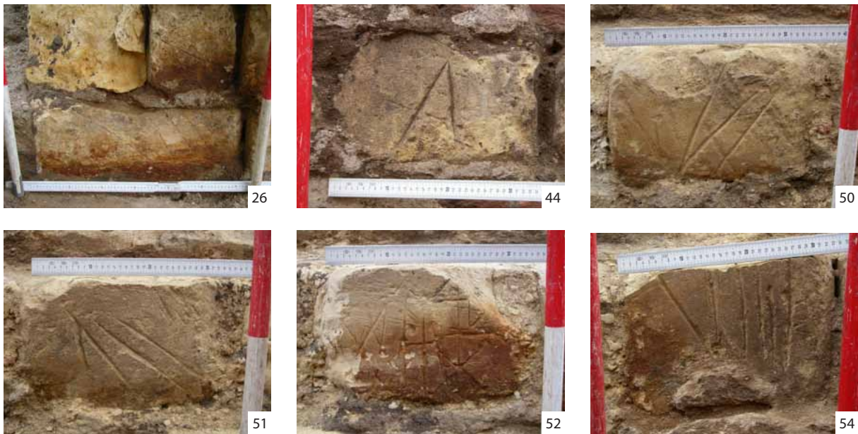
Figuur 13.6. Enkele voorbeelden van telmerken en tekens op mergelstenen. De volgnummers verwijzen naar stenen in P3 (26) en P1 (44–54), zie ook fig. 5.8 en 13.5. JO
